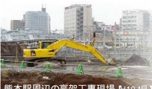
熊本駅周辺の高架工事現場 [H19.1月]
